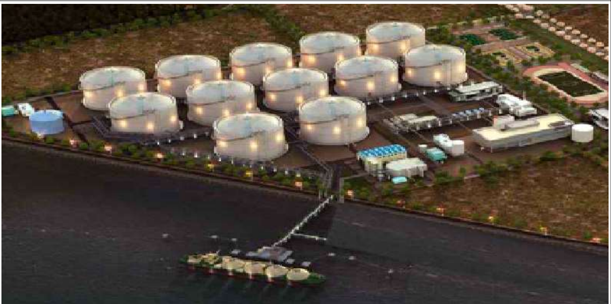
동북아 LNG Hub 터미널 부두
